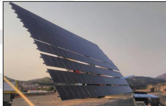
Cada dos seguidores se acciona un motor de 100 kW. Un tercer motor de la misma potencia está conectado a la red para completar los déficits.
