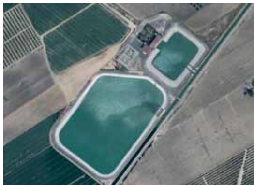
Fig. 2.9 Embalse regulador de la impulsión de Fuente Álamo
