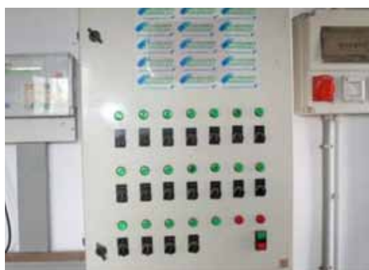
Fig. 5.9b Programador para riego automático (ETSIA-UPCT)
