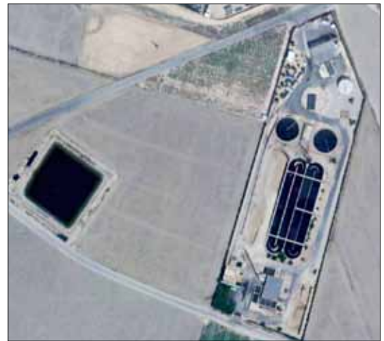
Fig. 6.8 Vista de la depuradora de Torre Pacheco (Julio 2007)
