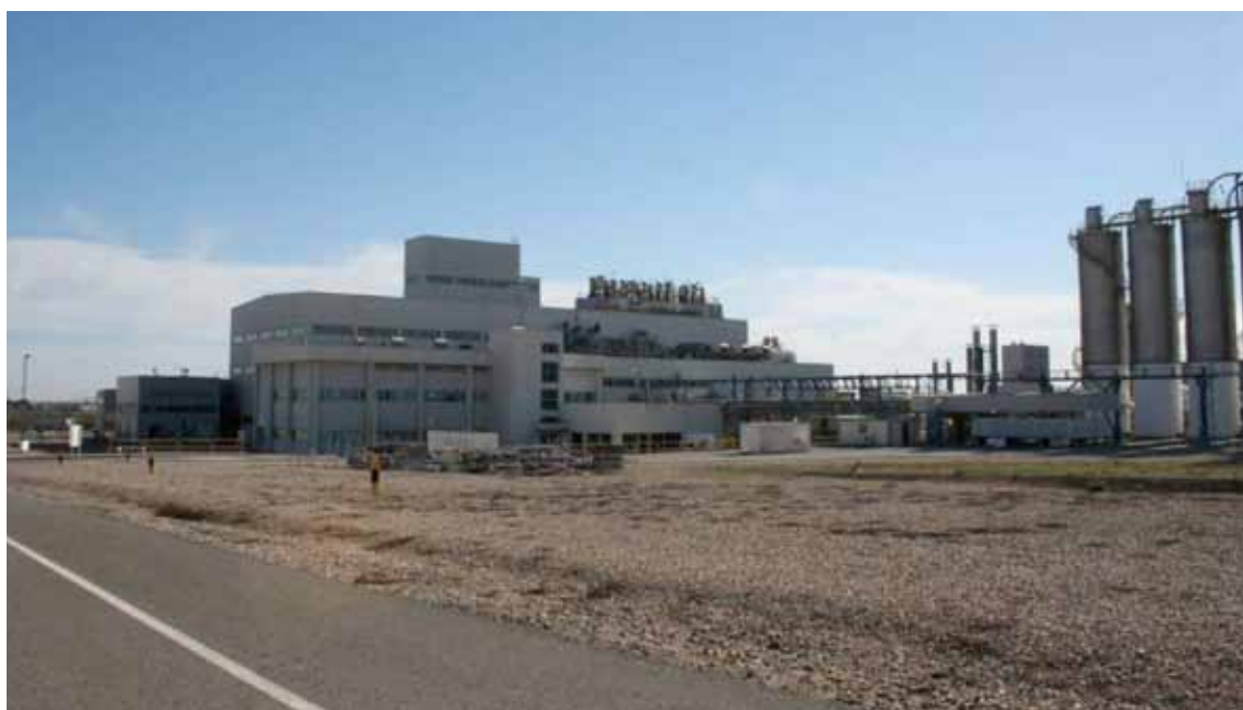
Fig. 4.15 Instalación de General Electric en el Campo de Cartagena
