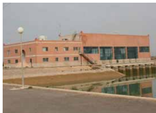
Fig. 2.8 Impulsión de Fuente Álamo del Trasvase Tajo-Segura
