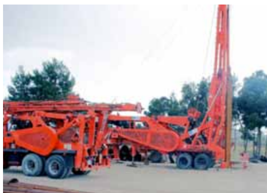
Fig. 3.6 Material para la realización de sondeos
