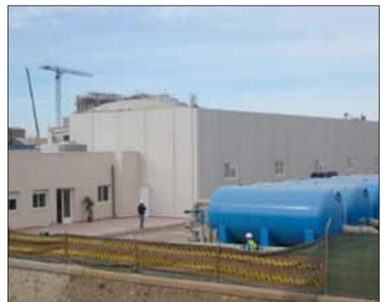
Fig. 6.10 Vista de la desaladora en el Valle de Escombreras
