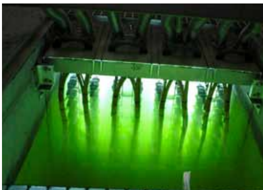
Fig. 2.15 Tratamiento con ultravioleta en una EDAR
