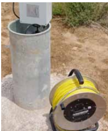
Fig. 4.19 Sistema de medición del nivel freático
