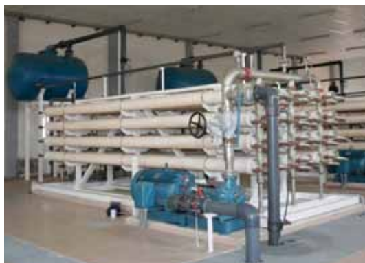
Fig. 3.10 Desaladora de aguas de drenaje de la CRC en el Mojón
